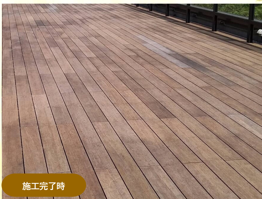
外壁材・デッキ材 支柱・手摺他
