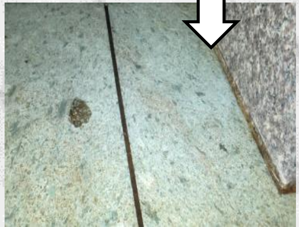
二年後の点検時も保護効果は持続しておりシミや汚れは発生していない
